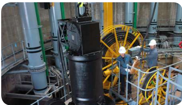
การบำรุงรักษาเครื่องสูบน้ำแบบ Submersible
