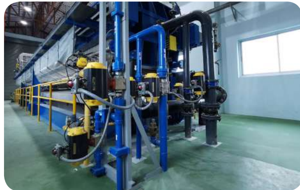
งานจัดหาติดตั้งระบบกำจัดตะกอน
