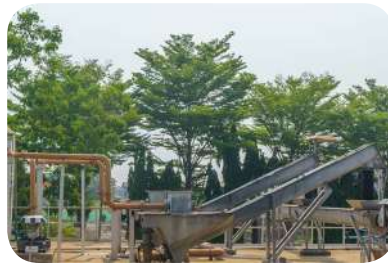
ถังดักกรวดทรายและรางดักกรวดทราย
