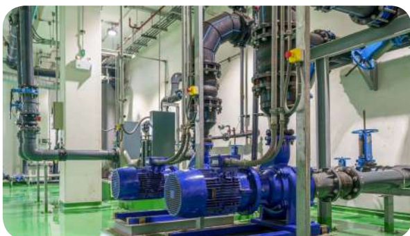
การบำรุงรักษาเครื่องสูบน้ำ แบบ Centrifugal
