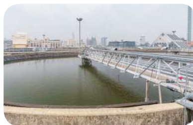
ถังตกตะกอน หรือบ่อซับตะกอน
